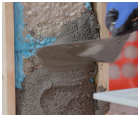
Applicazione di Planitop Ripara Facile
