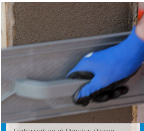
Frattazzatura di Planitop Ripara Facile
