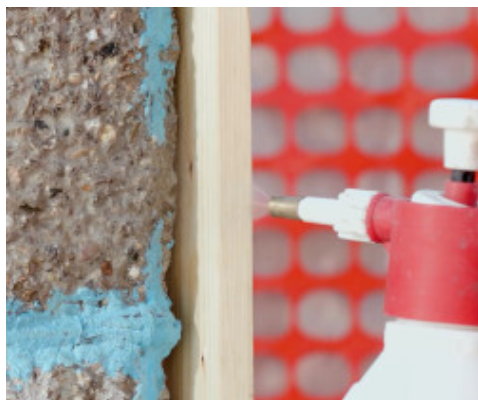
Preparazione e bagnatura del supporto
