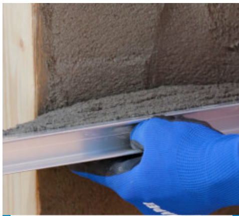
Staggiatura di Planitop Ripara Facile
